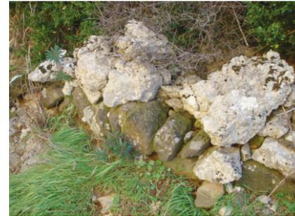
Mur de pierres posées à l'oblique pour le basalte gris et recouvert du calcaire local. (n°2)
